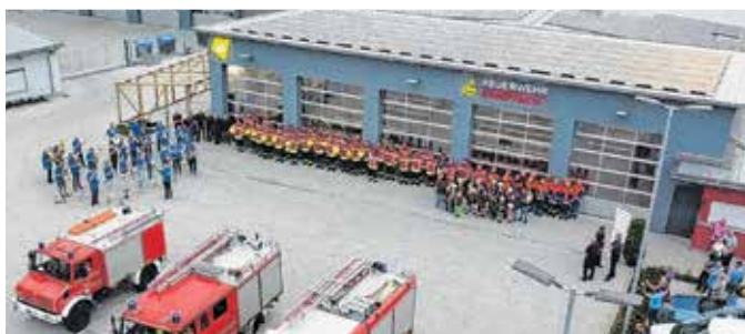
Nach rund zweijähriger Bauzeit konnte die Stimpfacher Wehr ihr neues Domizil beziehen.
