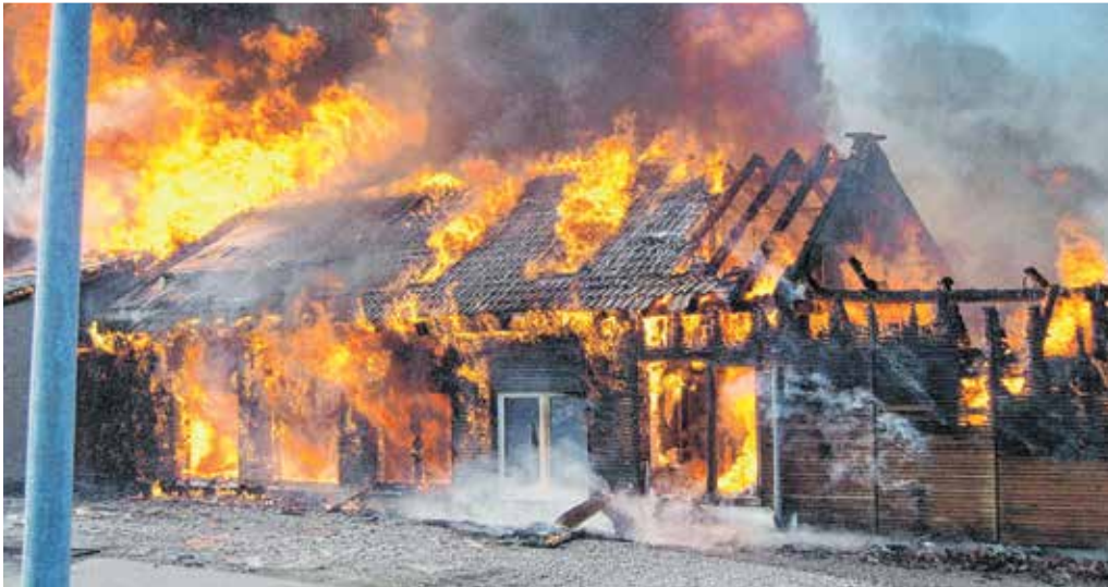
Flammeninferno: Ein Holzverarbeitender Betrieb brannte bis auf die Grundmauern nieder. Fotos: privat
