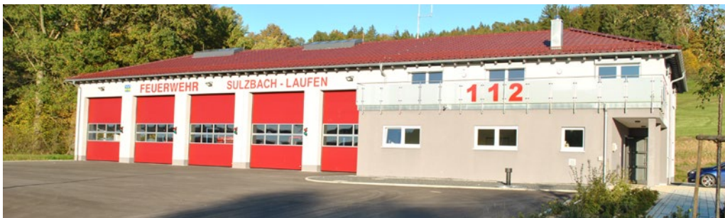
Das Feuerwehrgerätehaus erstrahlt im neuen Glanz.
