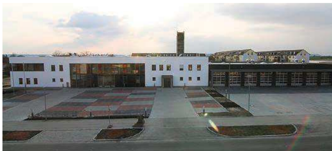
Feuerwache Ost mit Atemschutzübungsstrecke und Übungsturm.
