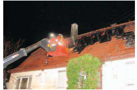
Dachstuhlbrand in Engelhardshausen.
