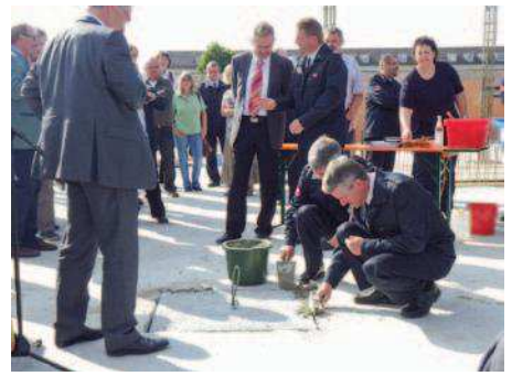
Bei der Grundsteinlegung (vorne v.l.): Oberbürgermeister Hermann-Josef Pelgrim, 1. Landesbeamter Michael Knaus, Stadtbrandmeister Volker Damm, (kniend) die stellvertretenden Kommandanten Christoph Wenger und Friedrich Steiner.
