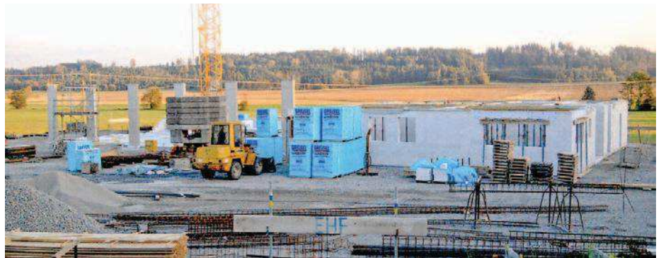
Baustelle des Kreßberger Feuerwehrmagazins Süd.
